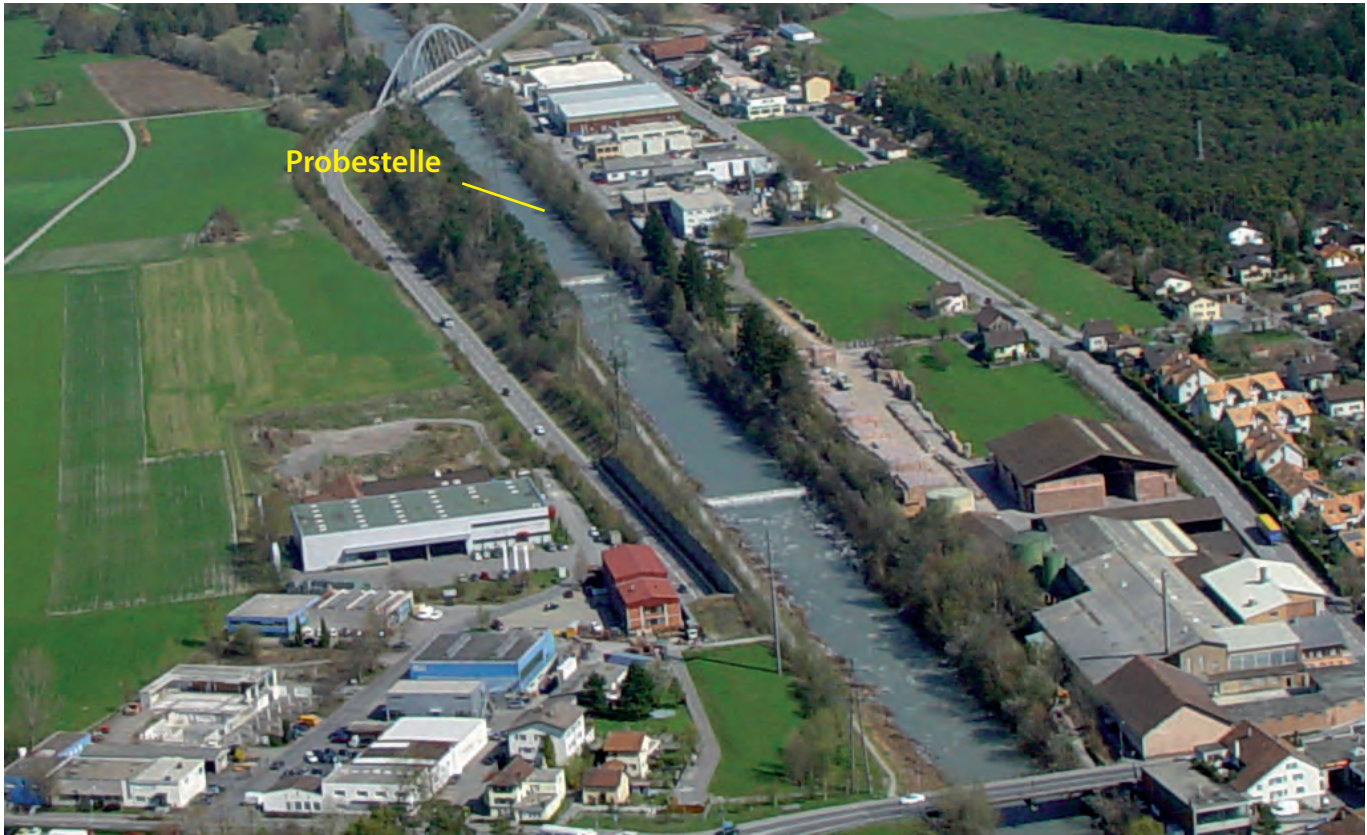
Abb. 31: Landquart oberhalb von Igis-Landquart. Die Schwellen wurden Ende 2009 in raue Rampen umgewandelt. Foto: HYDRA 2008 ©.
