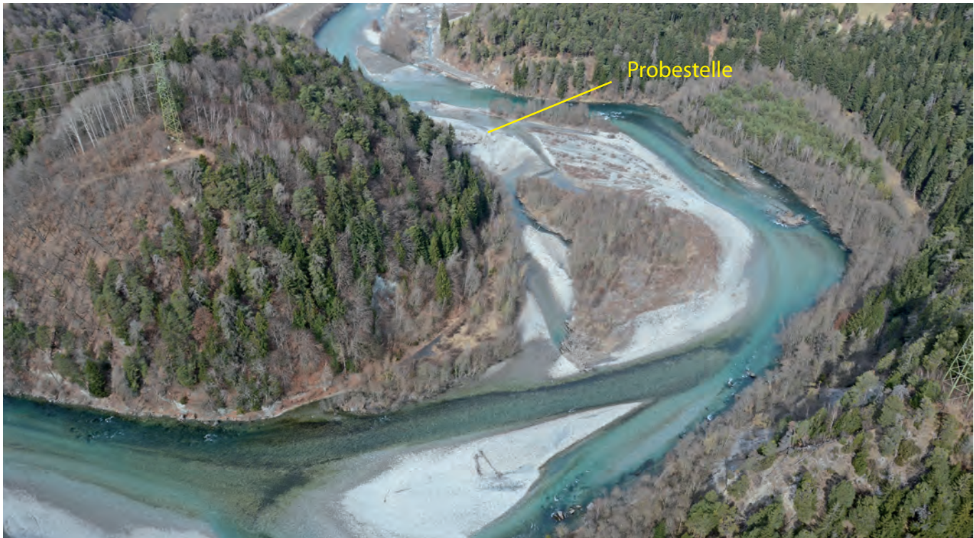
Abb. 22: Hinterrhein bei Bonaduz-Plazzas (GR), 1,5 Km oberhalb des Zusammenflusses mit dem Vorderrhein. Foto: HYDRA 2011 ©.
