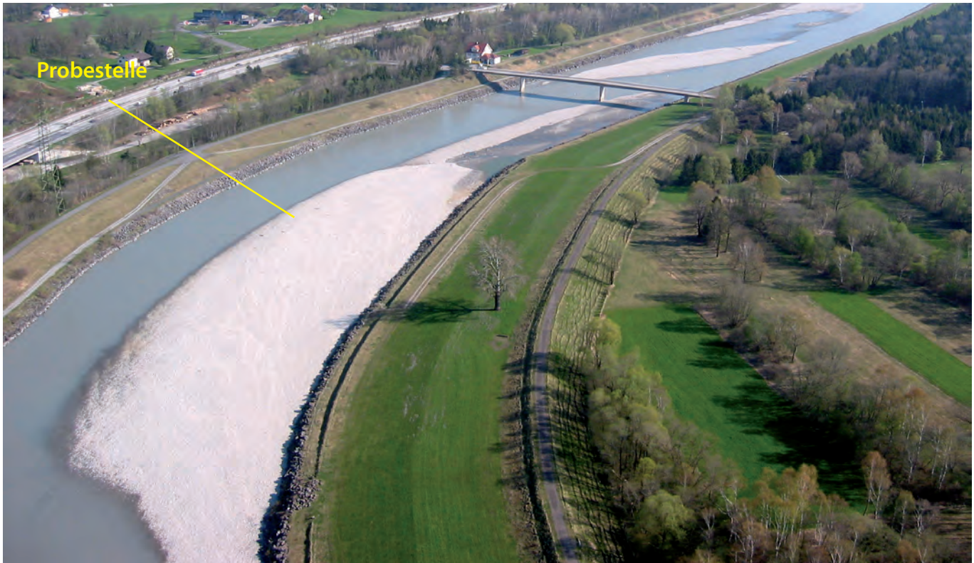
Abb. 40: Alpenrhein bei Bangs (V). Der untere Bildrand liegt etwa auf der Grenze Vorarlberg-Liechtenstein, der Rhein selbst trennt Vorarlberg vom Schweizer Kanton St. Gallen. Foto: HYDRA 2003 ©.
